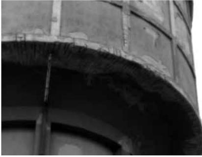
Figura 2 - Degradazione di strutture in presenza di cloruri
