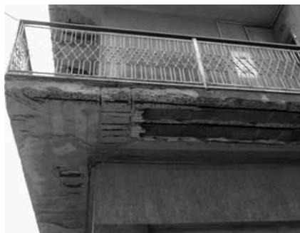
Figura 1 - Effetti corrosivi da carbonatazione
