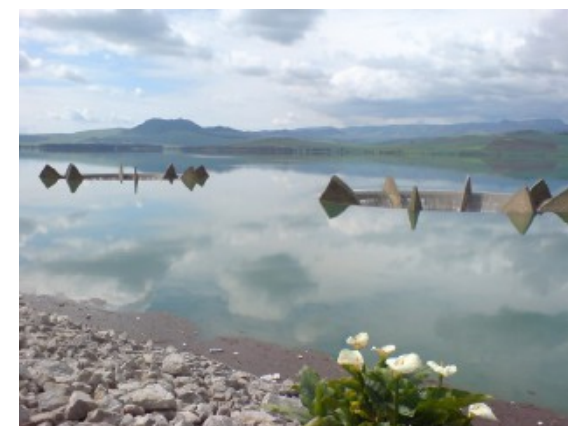
UN'IMMAGINE D'ARCHIVIO DELLA DIGA DON STURZO
